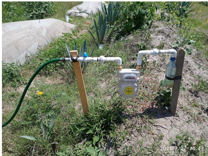
Anexo 15. Manguera de polietileno para la conducción del biogás, válvula para controlar el flujo del gas, medidor de gas de diafragma y válvula de alivio de la presión.
