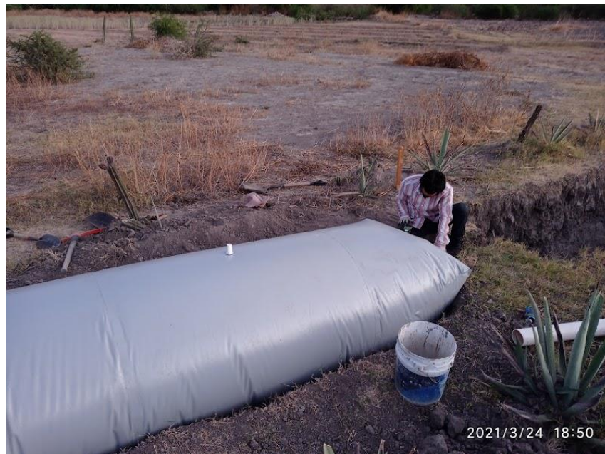
Anexo 13. Inflado de los biodigestores para su ubicación en el suelo.
