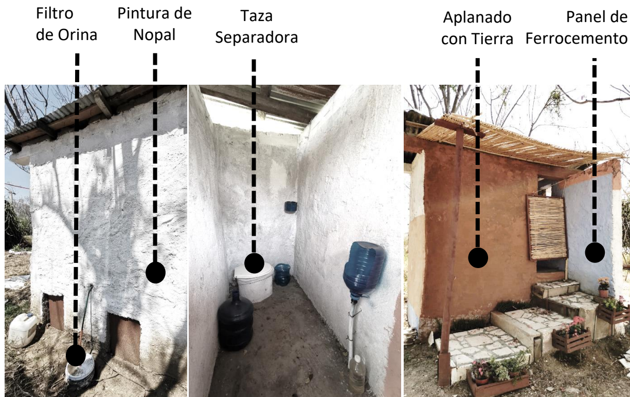
Figura 45. Ecotecias incorporadas en el prototipo de sanitario seco.
