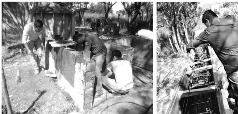
Figura 24 y 25. Prototipo de sanitario seco elaborado por alumnos y docentes del CIIDIR Unidad Oaxaca en obra negra (15 de agosto de 2018).
