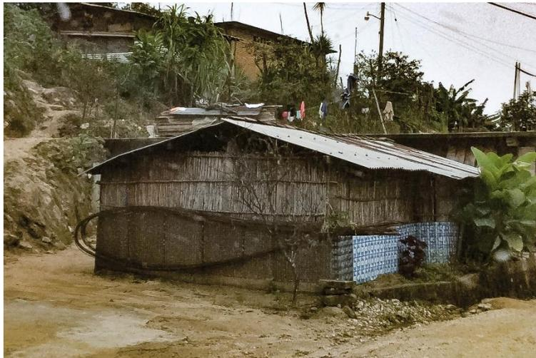
Figura 3. Vivienda de la Costa en el municipio de Santos Reyes Nopala, construida con muros de carrizo y cubierta de lámina. Fuente: A.R Cortés-Pérez, Junio 2014.
