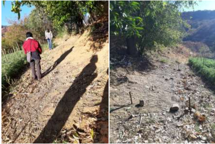
Figura 46. Determinación de lugar para construcción de biodigestor de bolsa.
