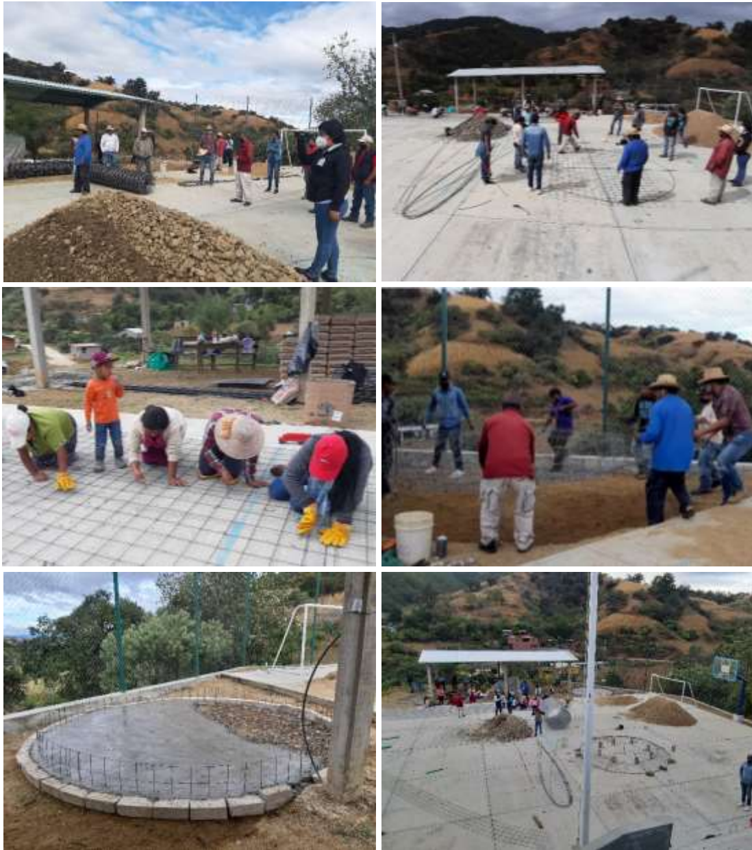
Figura 49. Taller de capacitación de construcción de tanques de almacenamiento de agua con la técnica de ferrocemento.
