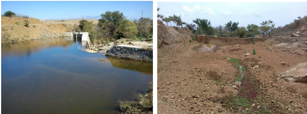
Figura 3. A la izquierda se muestra la presa agrícola secundaria con agua y a la derecha al vaciarse por apertura de compuertas.
