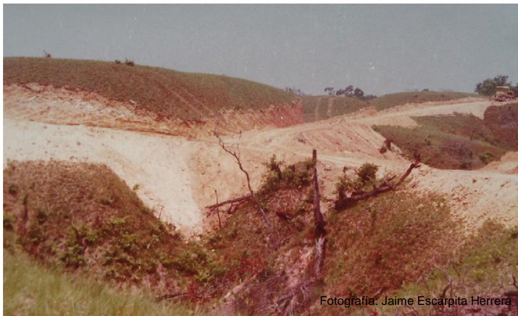
Figura 3. Construcción de caminos en 1974.
