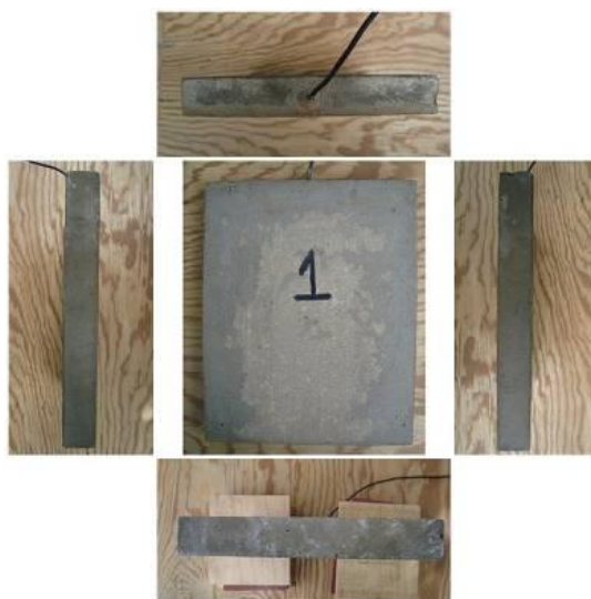
Figura 29: Inspección visual no destructiva detallada de placas de ferrocemento
