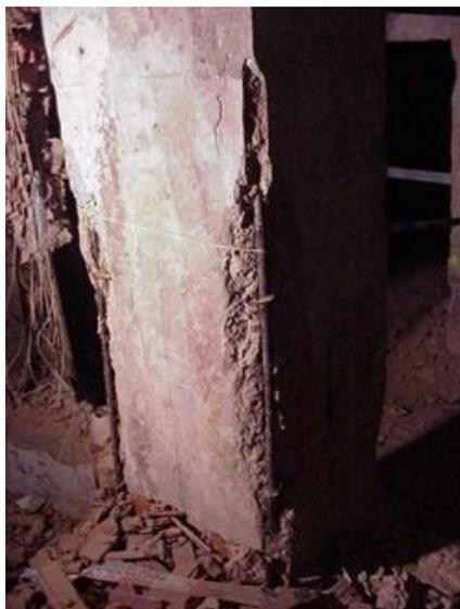
Figura 3- Columna de concreto afectada por la carbonatación.
