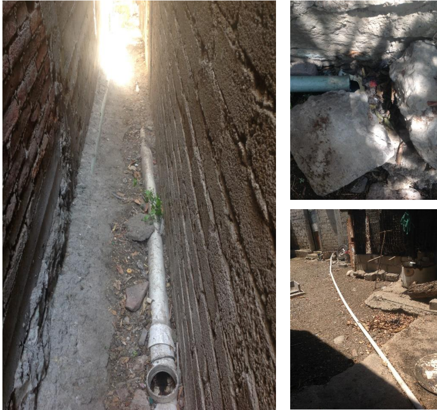
Figuras 46, 47 y 48. Canal de riego con aguas residuales en la vivienda de la Familia Sosa Núñez. Fuente: Propia tomada 07-03-2016
