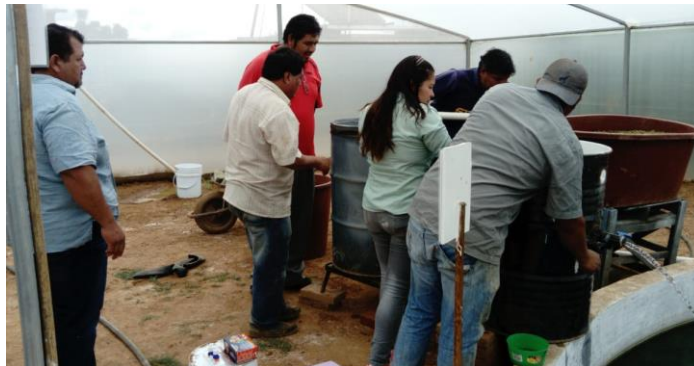
Figura 27. Acuicultores participando en la instalación del sistema de Filtración.
