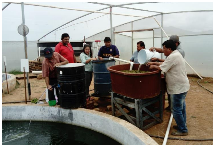
Figura 25. Instalación del sistema de filtración de agua.
